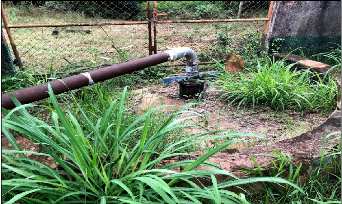
Figura 23 - Poço 01 – Detalhe do local de perfuração
