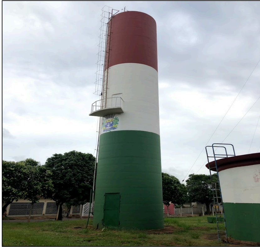
Figura 27 – Reservatório R-01 Apoiado
