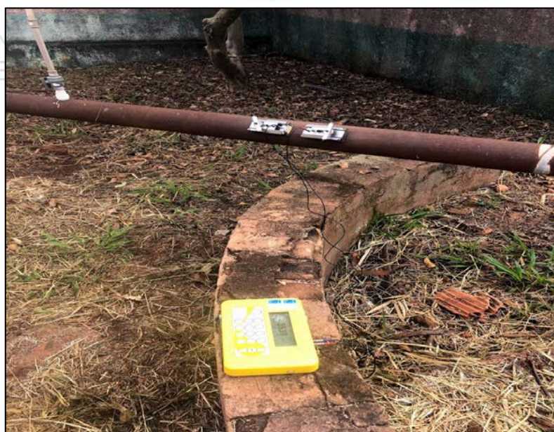
Figura 45 – Instalação do equipamento ultrassônico na tubulação do Poço 01
