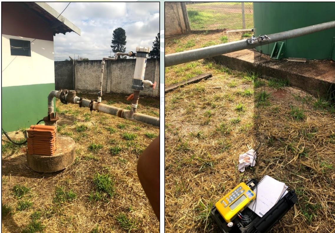
Figura 46 - Instalação do equipamento ultrassônico no Poço 04
