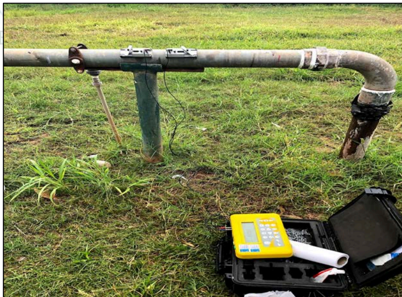
Figura 47 - Instalação do equipamento ultrassônico no Poço 05
