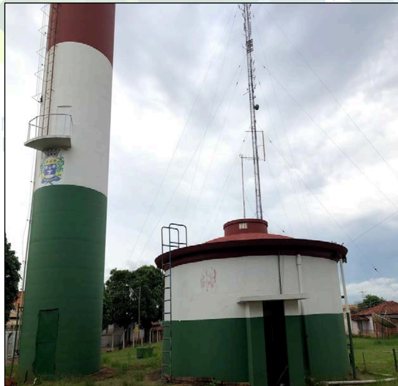
Figura 28 – Reservatório R-01 e R-02
