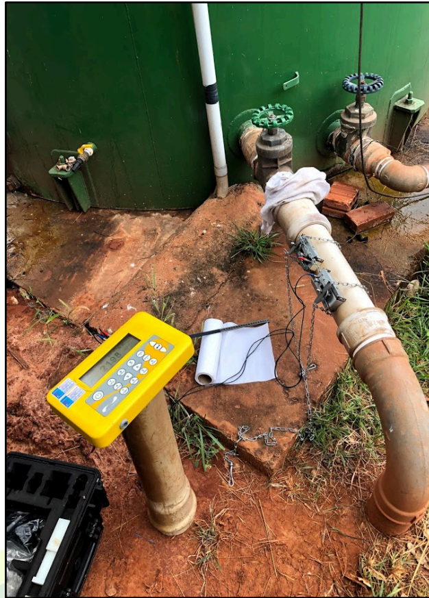
Figura 42 – Instalação do equipamento Ultrassônico no reservatório R-03
