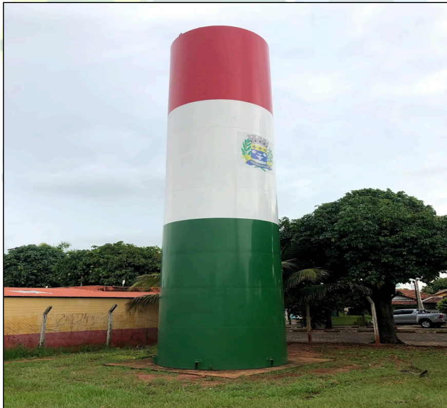
Figura 26 – Reservatório R-03 Apoiado
