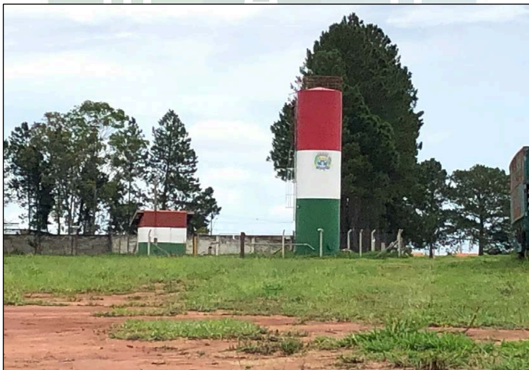
Figura 33 – Poço P-04 e Reservatório R-05
