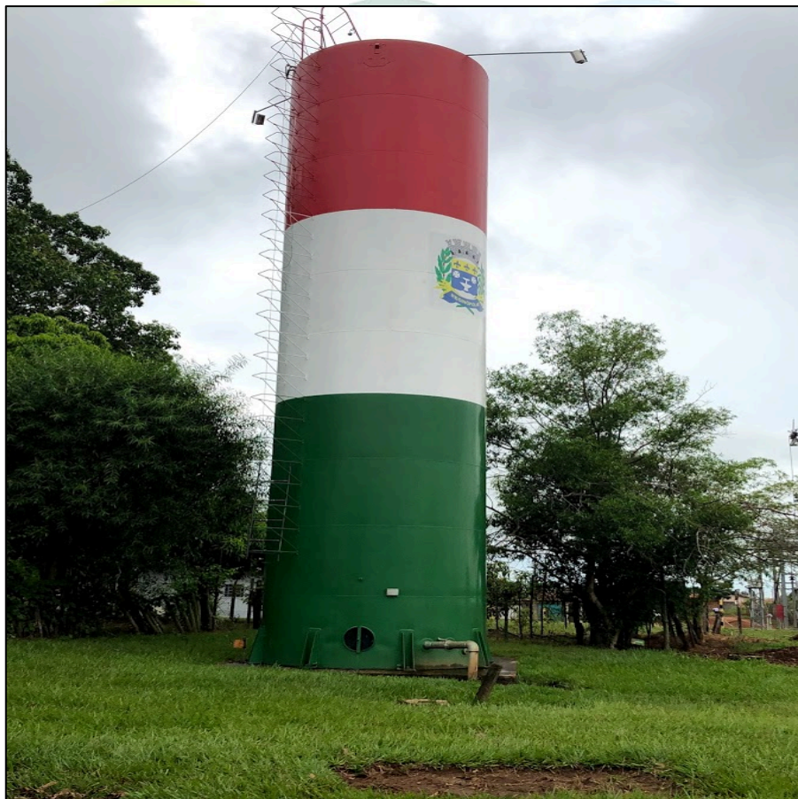
Figura 32 – Reservatório R-04 Apoiado
